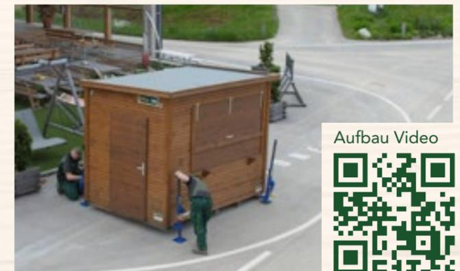
Schrittweises Herunterkurbeln bis fertiges Niveau
