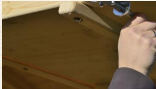
Schnellverschluss durch Federrigel
