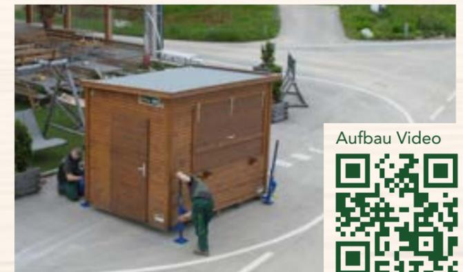
Schrittweises Herunterkurbeln bis fertiges Niveau
